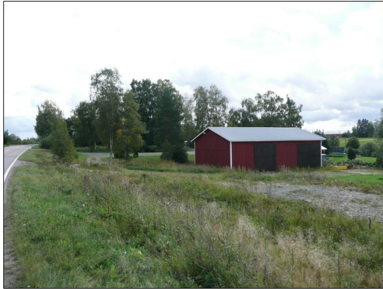
Kylätontin eteläosaa rakennuksen takana, itään.
